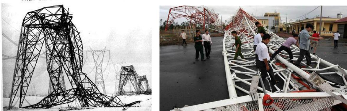
Figura I. 9. Torres colapsadas por viento. Izq.: de transmisión. Der.: de telecomunicaciones [5]
