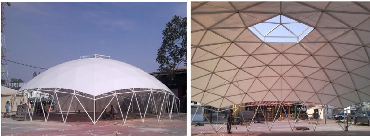
Figura I. 4. Estructura de barras esquelética espacial. Izq.: domo, vista exterior, Der.: interior [F.P.]
