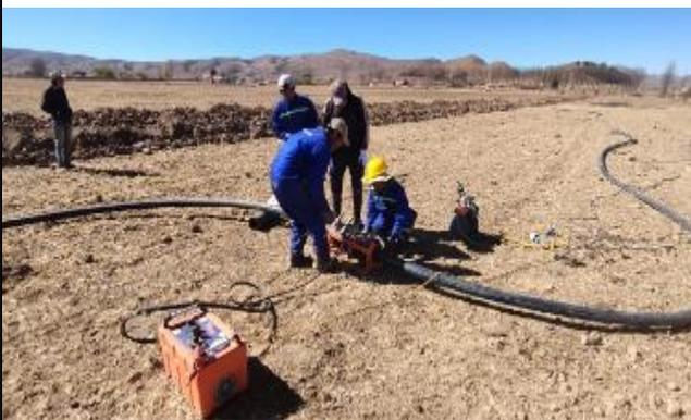
**Actividad:** provisión y colocados de tubería PEAD 90 MM PN8 (termofusión)
