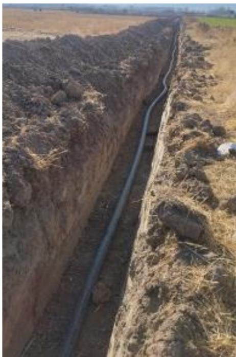
**Actividad:** cama de arena de relleno margen izquierdo. Provisión y colocado de tubería PEAD 90 MM PN12.5.
