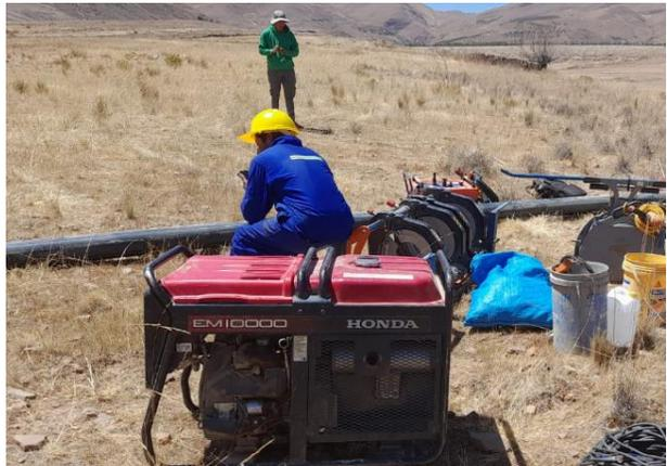
**Actividad:** provisión y colocado de tubería PEAD 200 MM PN6 (termofusión)
