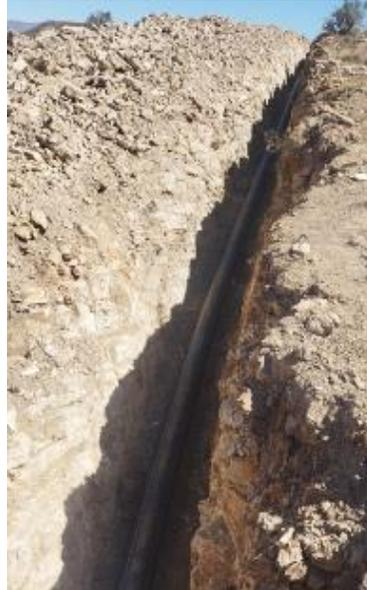
**Actividad:** cama de arena de relleno margen derecho. Provisión y colocado de tubería PEAD 200 MM PN6PEAD 160 MM PN8.
