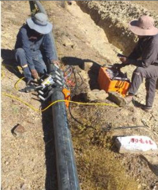
**Actividad:** provisión y colocado de tubería PEAD 160 MM PN8 (termofusión)
