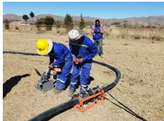
**Actividad:** provisión y colocados de tubería PEAD 90 MM PN8 (termofusión)
