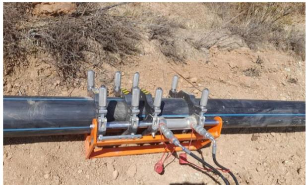
**Actividad:** provisión y colocado de tubería PEAD 160 MM PN8 (termofusión)
