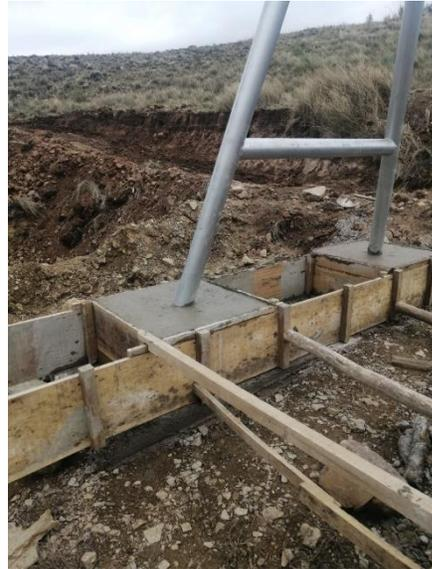
Vaciado de la mezcla de concreto en las bases de las torres.
