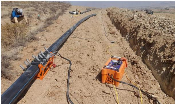
**Actividad:** provisión y colocado de tubería PEAD 200 MM PN6 (termofusión)
