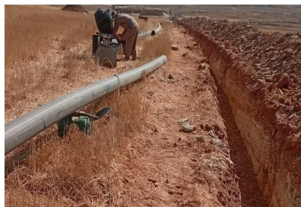
**Actividad:** provisión y colocado de tubería PEAD 110 MM PN12.5 (termofusión)
