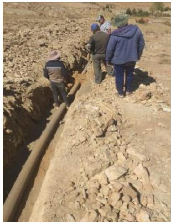
**Actividad:** cama de arena de relleno margen izquierdo. Provisión y colocado de tubería PEAD 160 MM PN6.
