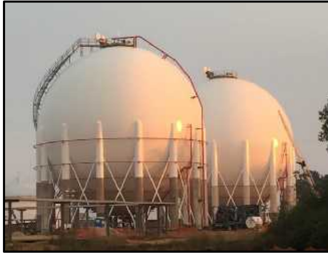
Figura 4. Tanques esféricos.
