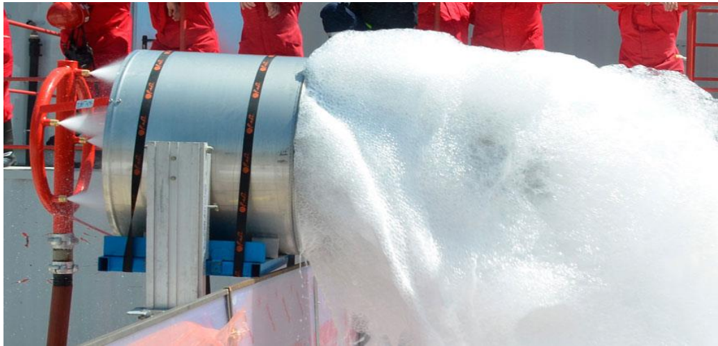
Figura 3: Sistemas de espuma de aire comprimido.
