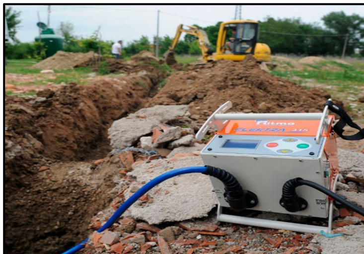
Figura 17: Soldadura de termo fusión
