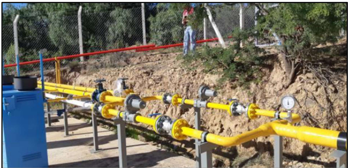
Figura 7. Puente de Regulación Primario
