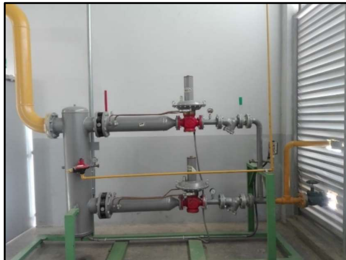
Figura 8. Puente de Regulación Secundario
