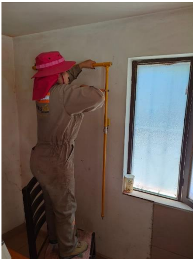
Figura 6. Ensamblado de toma para cocina
