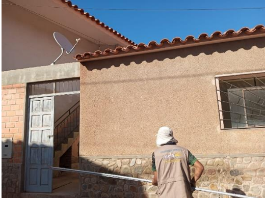
Figura 1. Personal cargando tubería
