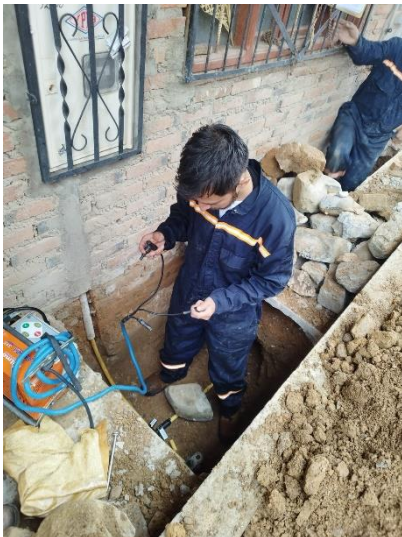
Figura 4. Conexión de acometida
