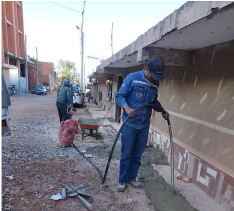
Figura 2. Reposición de veredas
