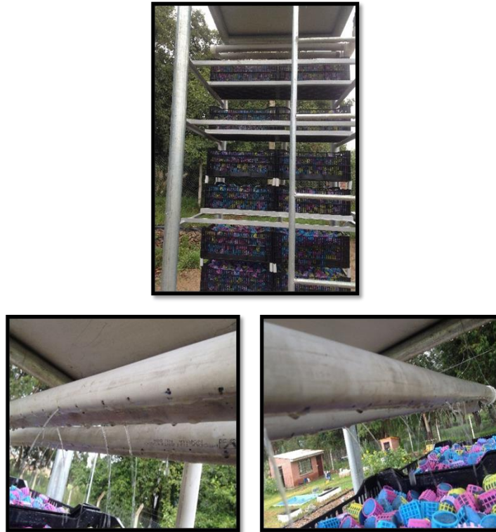
Figura 17. Lecho filtrante y tuberías de distribución
