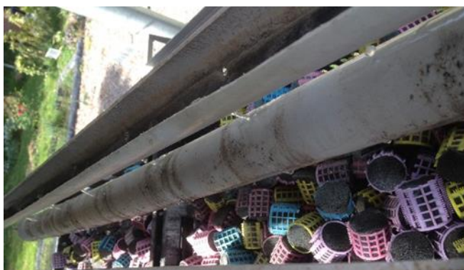
Figura 20. Canal de distribución
