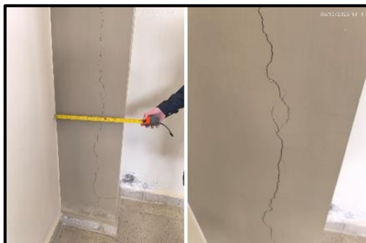
Figura 3.12. Piso interno - columna (N2) Eje E'5
