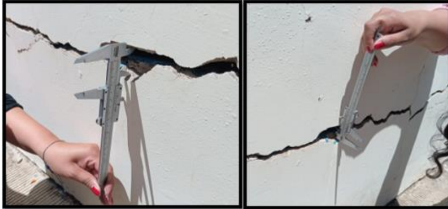
Figura 3.13. Muro Externo (PB) E1-D1 12.28
