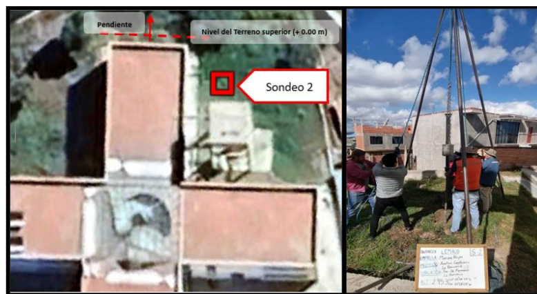
Figura 3.28. Ensayo SPT – Sondeo 2
