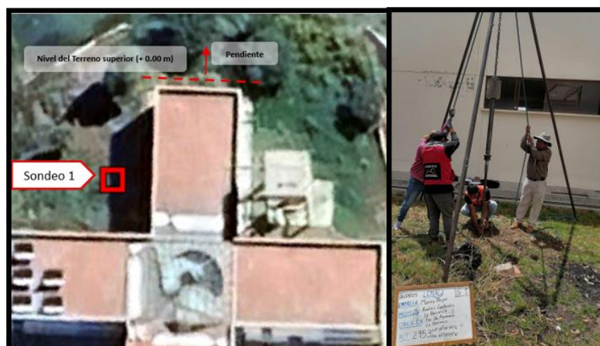
Figura 3.27. Ensayo SPT – Sondeo 1
