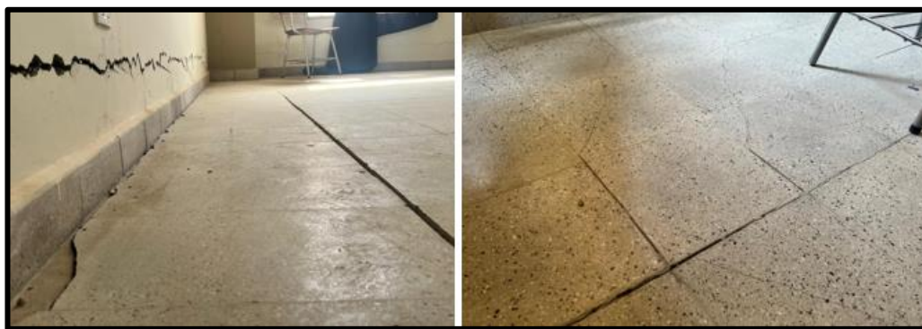
Figura 3.10. Piso interno (N2) Eje D3-D2
