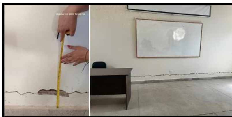
Figura 3.9. Muro interno (N1) y Muro interno (N1) Eje E1-E2
