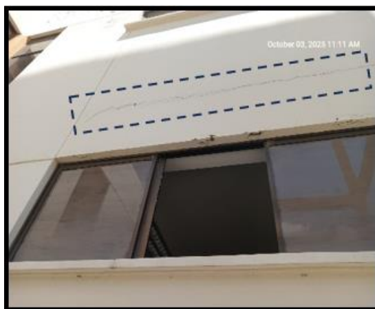
Figura 3.5. Muro externo nivel 1: Eje: D2-D3
