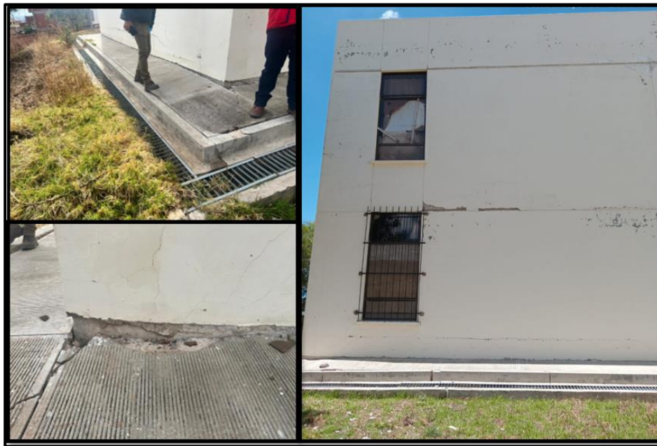
Figura 3.14. Muro Externo (PB) - (N2) Eje E1
