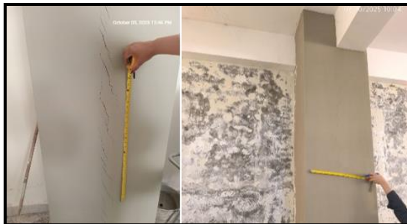
Figura 3.11. Piso interno - columna (N2) Eje D3-D2
